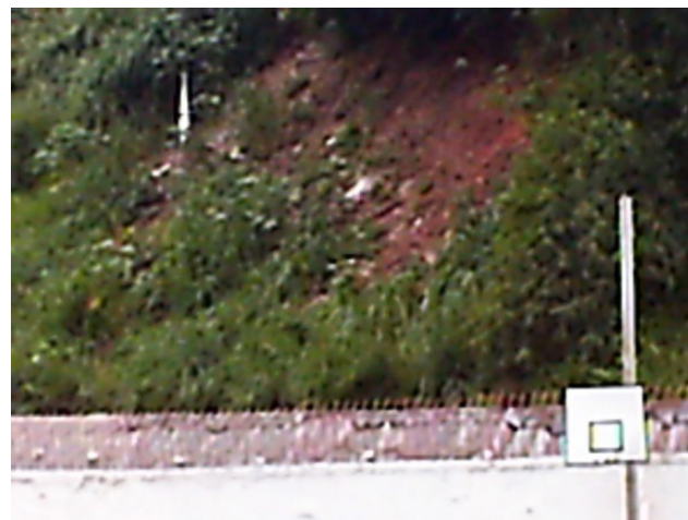
Figura 3. Desnudamento da encosta e acúmulo de lixo (2012).
